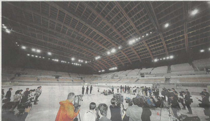
完成し、報道陣に公開された有明体操競技場。梁に信州産カラマツを使った＝2019年10月、東京都江東区
